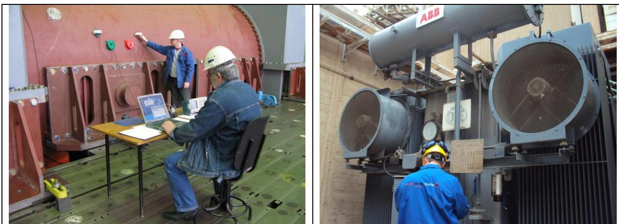
Durante il normale funzionamento della macchina vengono applicati speciali sensori magnetici in diversi punti della carcassa della macchina e sulla treccia della messa a terra, collegati ad appositi analizzatori che forniscono istantaneamente una serie di valori.
